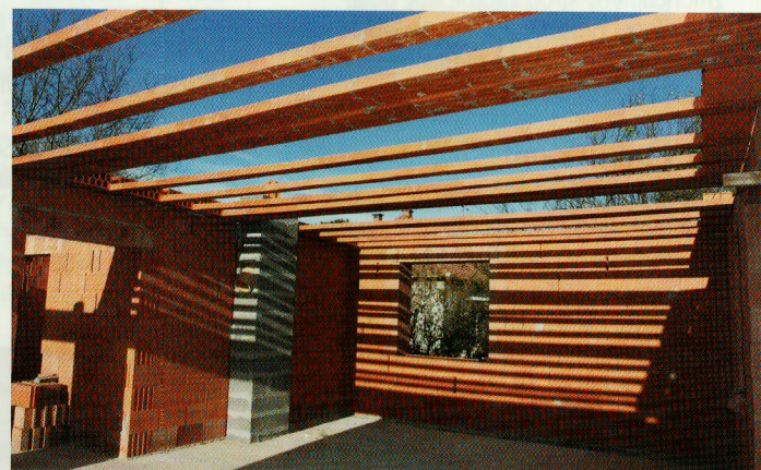
Ukladanie nosníkov
