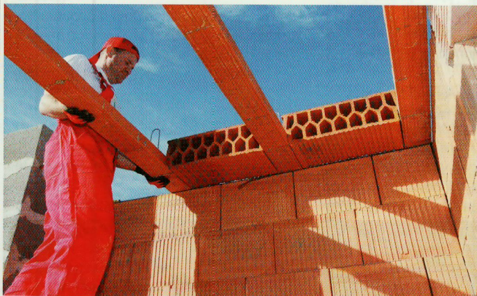
Ukladanie nosníkov
