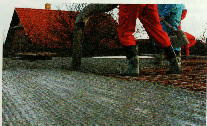
Betonáž stropu
